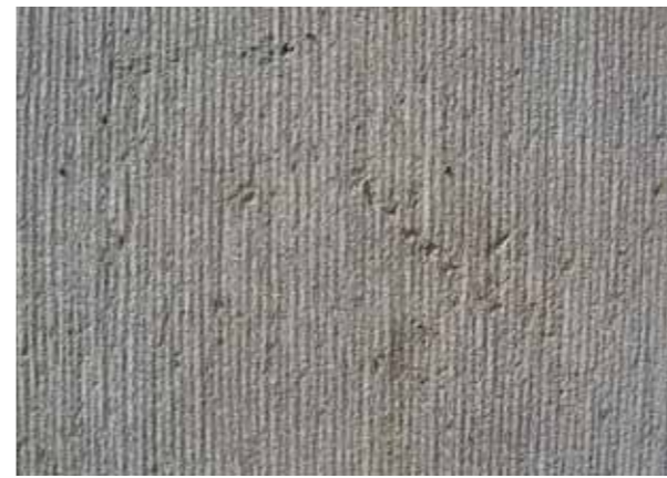
Fig 7.9 Skrädhuggen kalstensyta. Rosenbad, Stockholm
