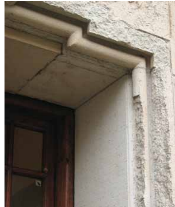
Fig 3.18 Stora materialförluster på grund av klovförsvagnig. Högbergsgatan 11, Stockholm.
