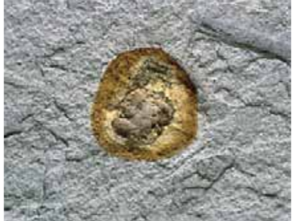
Fig 3.11 Rostande pyritklump i gotländsk sandsten. Vamlingbo kyrka, Gotland
