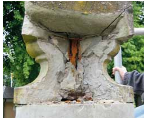
Fig 3.32 Korrosionssprängningar i solur. Almunge kyrkogård, Uppland.
