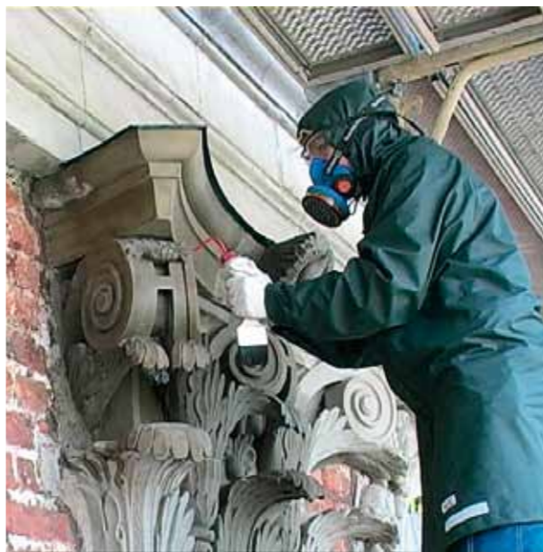
Fig 4.9 Konsolidering med kiselsyraester. Riddarhuset, Stockholm
