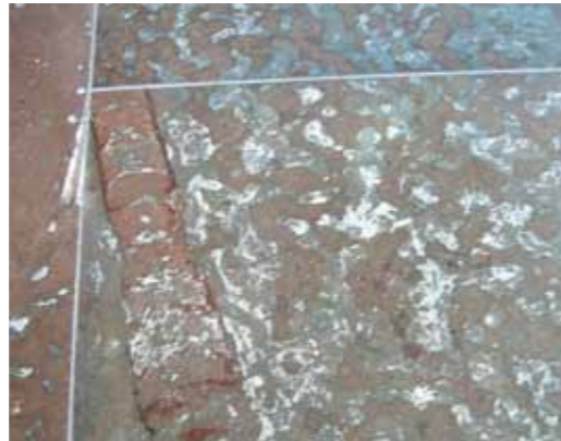
Fig 3.29 Saltvittring i kalkstensgolv.
