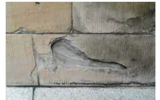
Fig 3.20 Exfolieringsskador, Gotlandssandsten(karbonatbunden). Tyska kyrkan, Stockholm
