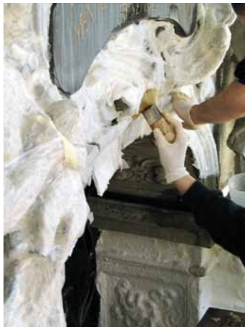
Fig 4.8 Avsaltning. Cellstoft appliceras på stenen. Petersenska huset, Munkbron, Stockholm
