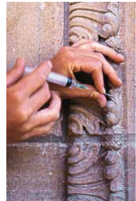
Fig 4.3 Säkring genom injektlimning. Gamla Krematoriet, Örebro.
