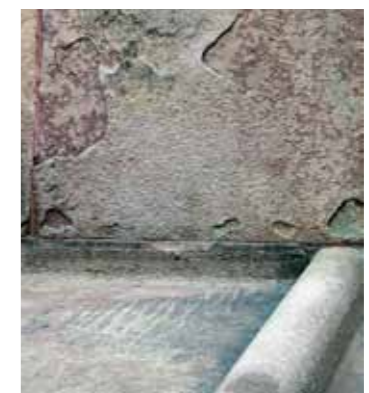
Fig 3.21 Exfolieringsskador, Roslagssandsten (kvartsitbunden). Storkyrkan, Stockholm.
