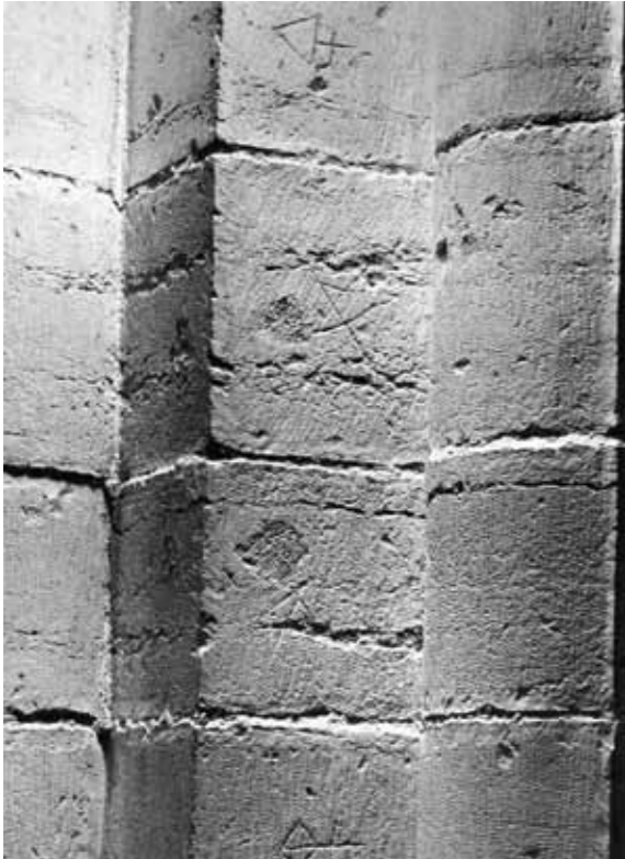
Fig 2.2 Historiska dokument är bärare av information. En över 700 år gammal tandhuggen kvadersten från Linköpings domkyrka bär vittnesbörd om den tidens nya bearbetningsteknik. Genom konserveringen bevaras originalmaterialet som källa till kunskap för dagens och morgondagens samhällen. En utbytt sten är också ett historiskt dokument, men den vittnar inte om objektets ursprungliga historia utan om dess restaureringshistoria.
